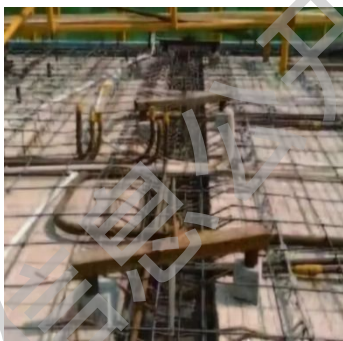
图 3.28 叠合板拼缝段支模
