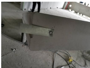
图 3.15 安装设置管卡
