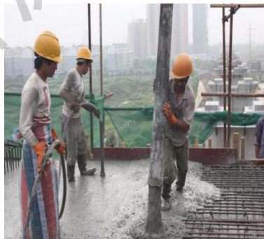
图 3.29 现浇层混凝土浇筑、养护
