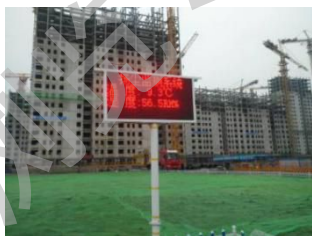
图 4.4 施工噪声、扬尘监控
