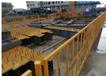
(b) 带栓钉钢构件堆放
