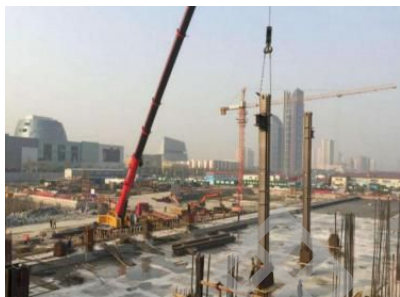
图 3.4 钢柱吊装
