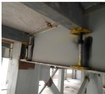
图 3.24 叠合板自承式支撑
