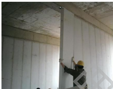
图 3.16 安装板材就位
