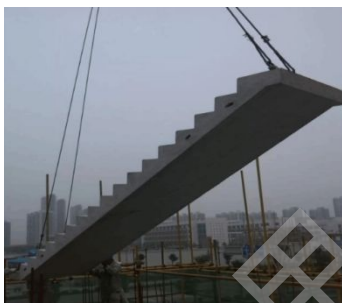
图 5.2 预制楼梯吊装
