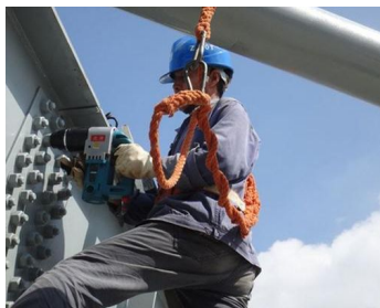
图 3.11 螺栓紧固
