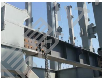
图 3.10 螺栓穿孔
