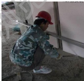
图 3.20 下端缝隙处理
