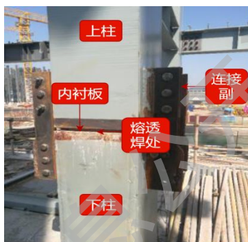
图 3.6 钢柱节间焊接拼接
