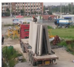
(a) 安装前检查
