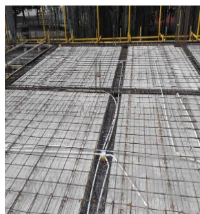
图 3.27 管线预埋、钢筋绑扎
