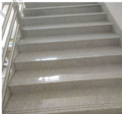
图 3.38 建筑面层施工
