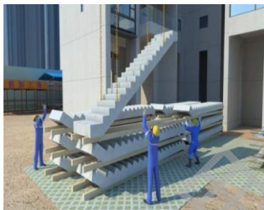
图 3.32 预制楼梯起吊
