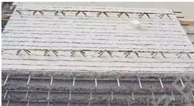
图 5.7 预制钢筋桁架叠合楼板
