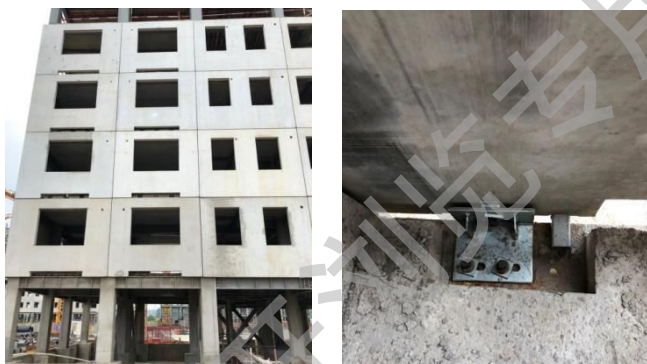
图 2.1 钢结构外挂墙板及连接图
