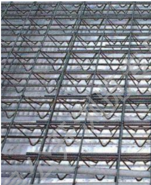
图 5.6 钢筋桁架组合楼板图
